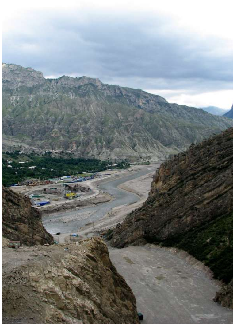
Фото №23. Р. Аварське Койсу, будівництво греблі ГЕС біля пос. Чалда
